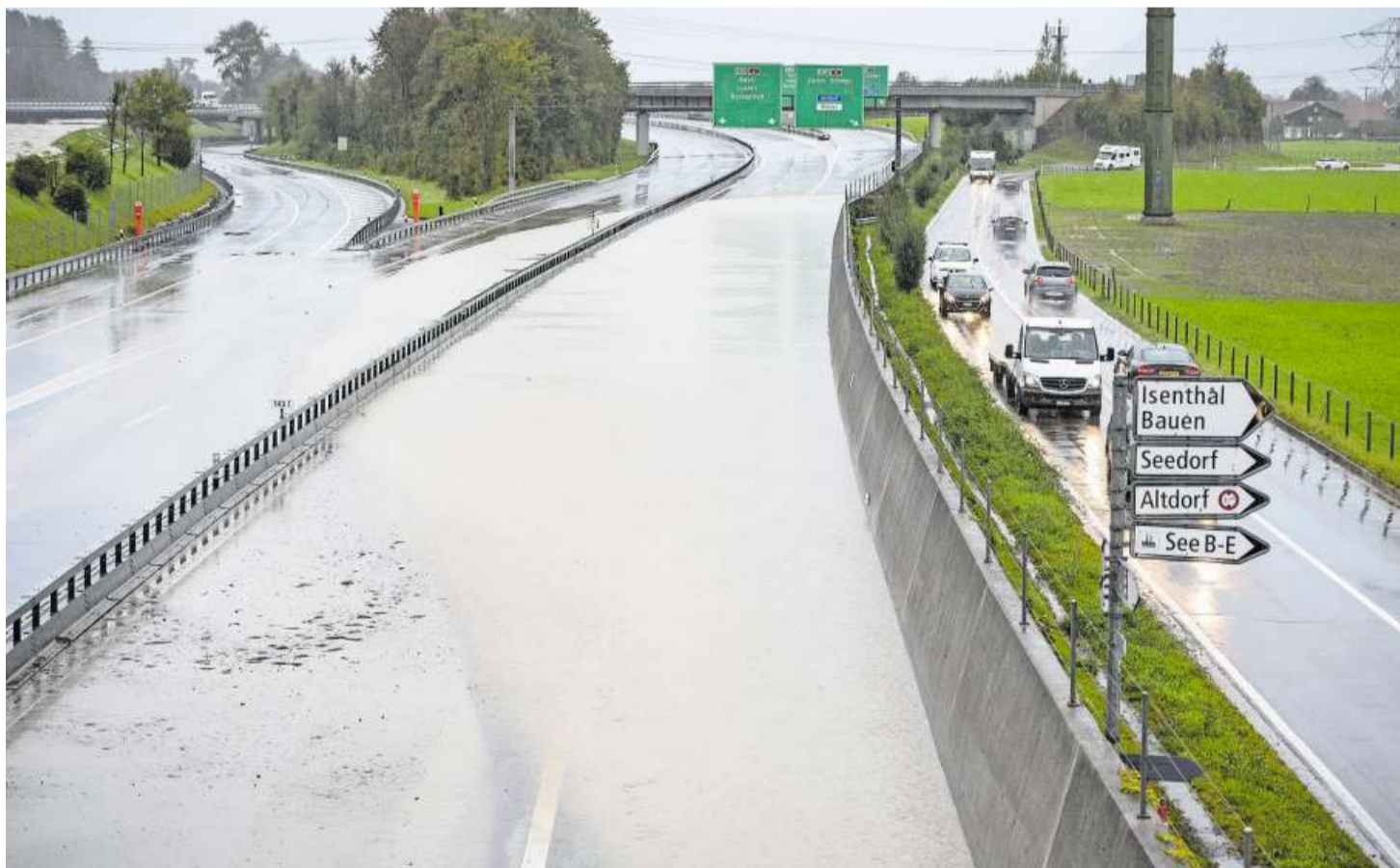
Anfang Oktober 2020 wurde die Autobahn A2 in Uri wegen Hochwasser gesperrt, damit die über die Ufer getretene Reuss kontrolliert ablaufen konnte. Bild: Urs Flüeler/ Keystone (Seedorf, 3. Oktober 2020)
